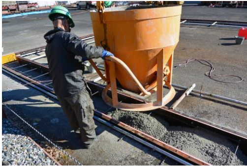
▲コンクリート流し込み作業
