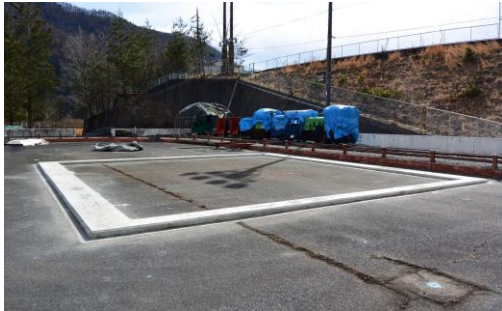
▲基礎工事完了の新車両庫。これから建屋工事が開始
